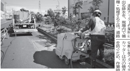
道路カッターと専用の給・排水ホースをつなぎ作業する(写真奥が移動式中間処理施設)
